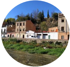
Muro de la calle Caldereria Baja
