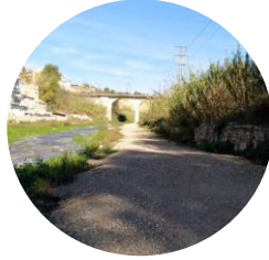
Muro de contención paseo fluvial
