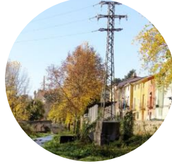
Torre eléctrica en DPH
